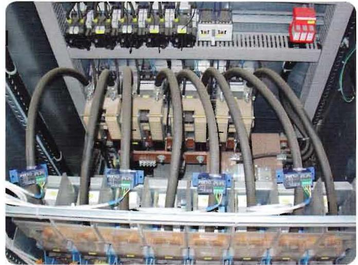
Figura 3: Vista dei sensori installati sulle linee in ingresso agli inverter
